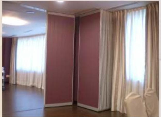
Módulos de hasta 1200 mm de ancho compuestos por doble tablero de 10, 13 ó 16 mm en melamina o vinilo, con cámara de aire o aislamiento interior. Tablero macizo de 30 mm o cristal laminar de 5+5.
